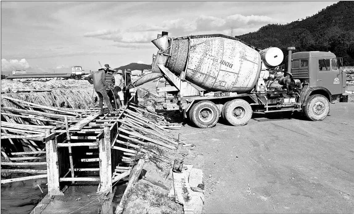
Thi công hạ tầng KCN Nhơn Hòa giai đoạn 2.
